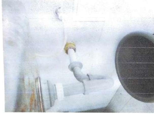
Se instala accesorio mejorando el recorrido del agua
