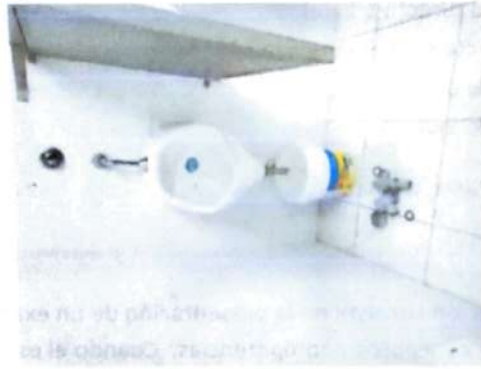
SE REALIZA DESTAPONAMIENTO
