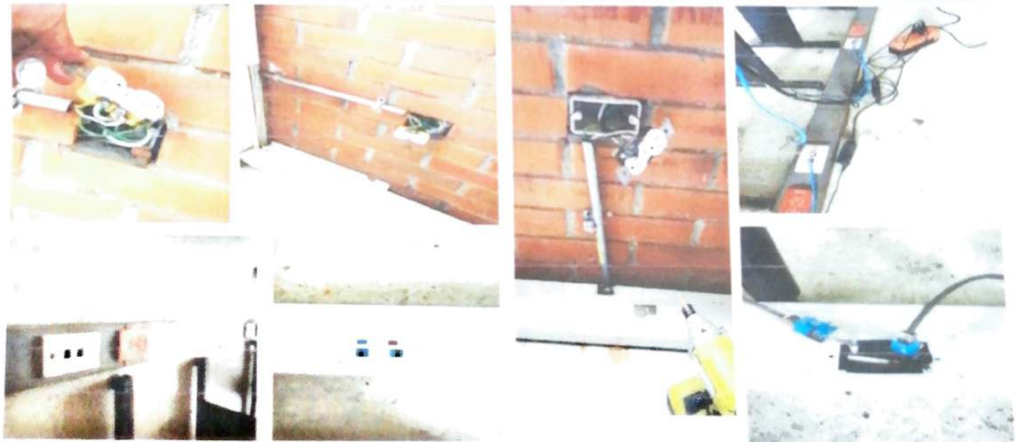
Reparación y cambios en 10 puntos de red y puntos eléctricos averiados en sala de sistemas
